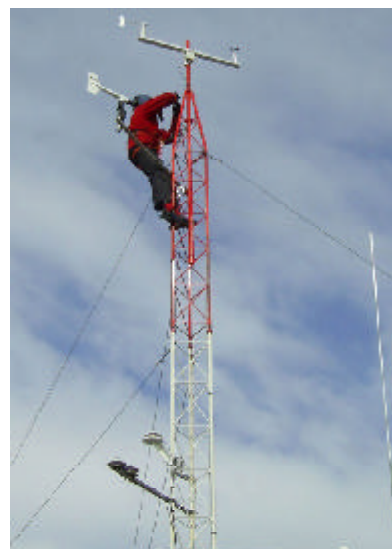
Colocando los instrumentos en la torre
