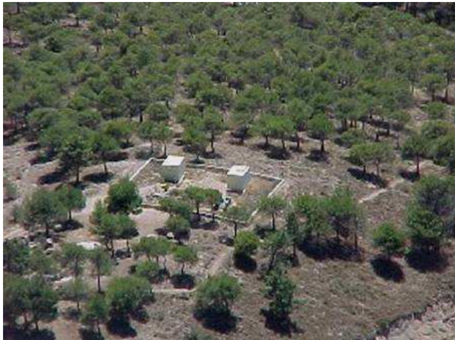
Estación de Víznar (Granada)
